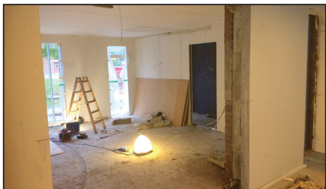
Den nye tilbygning midt i processen.
